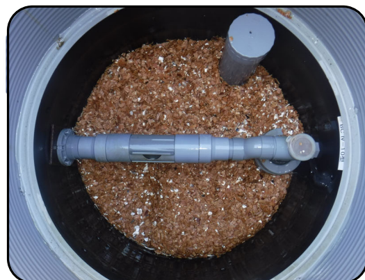
嵩上げ状況確認
