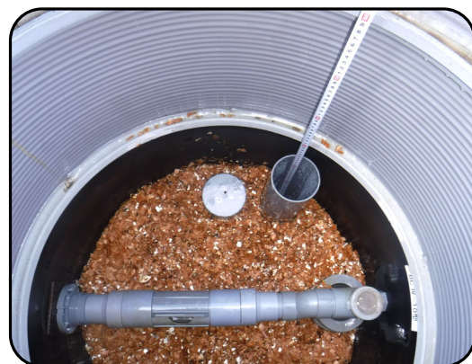
検水管内水位確認状況
