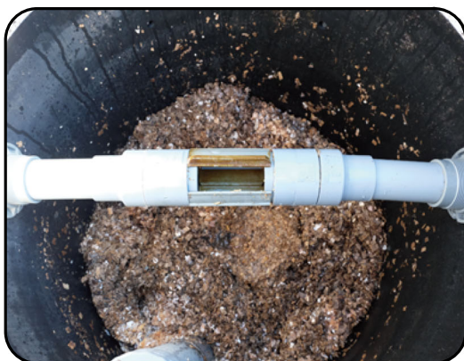
回転ゲート調整 全閉状態
